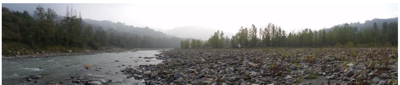
**FOTO 16** - Vista da nord a sud: a sinistra si osserva la sponda destra del Fiume Secchia sulla quale sono stati realizzati pennelli e ripacimenti come opere di sistemazione idraulica. In sponda sinistra si trova il terrazzo interessato dalla cava La Gavia (Foto Costa – ottobre 2014).
