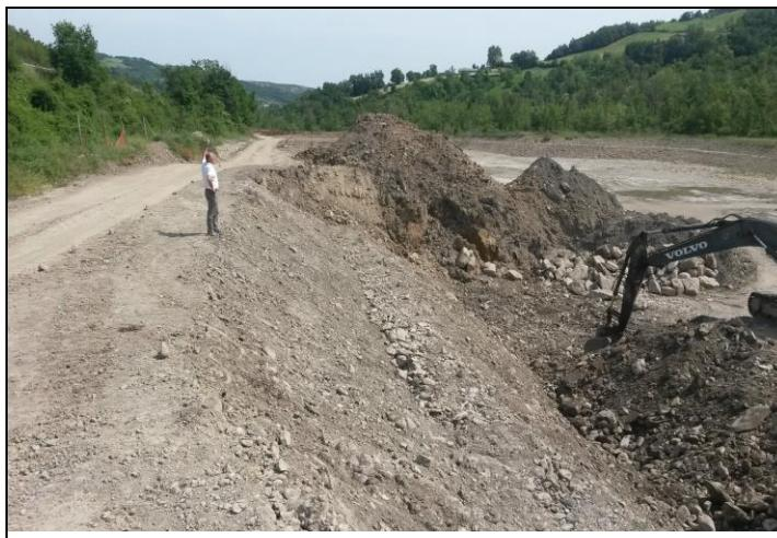
Figura 2.21 Scarpata di scavo in fascia di deroga e fase di rinterro settore PAE1. Foto G. Bonini 13/05/2015
