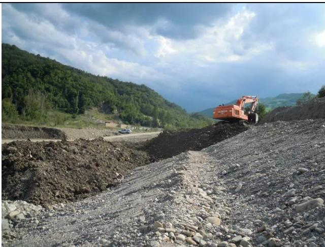
Figura 2.18 Scarpata di abbandono scavo in deroga e fase di rinterro. Foto G. Bonini 07/08/2014
