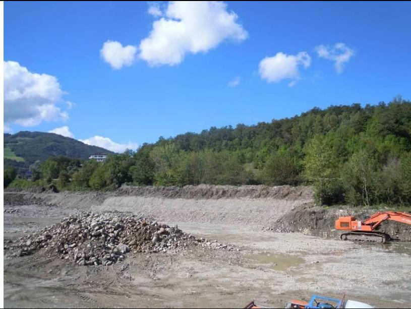
Figura 2.20 Fronte di scavo. A sinistra area in ripristino con rinterro di terreno extracava; nella zona centrale fronte con profilo di abbandono, a destra porzione del fronte ancora da scavare e scoticare.
