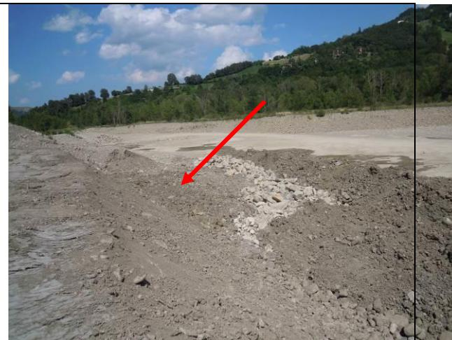
Figura 2.19 Piede corpo di frana sepolto (in figura indicato dalla freccia) con scogliera al piede e rinterro a valle. Foto G. Bonini 12/08/2014
