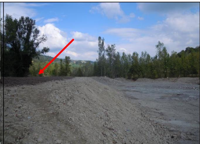
Figura 2.22 Scarpata di ripristino sponda sinistra zona PAE2. A monte area con ammendante. Foto G. Bonini 15/09/2015
