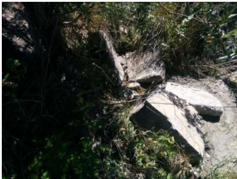
Foto 11: particolare della briglia in cemento crollata
