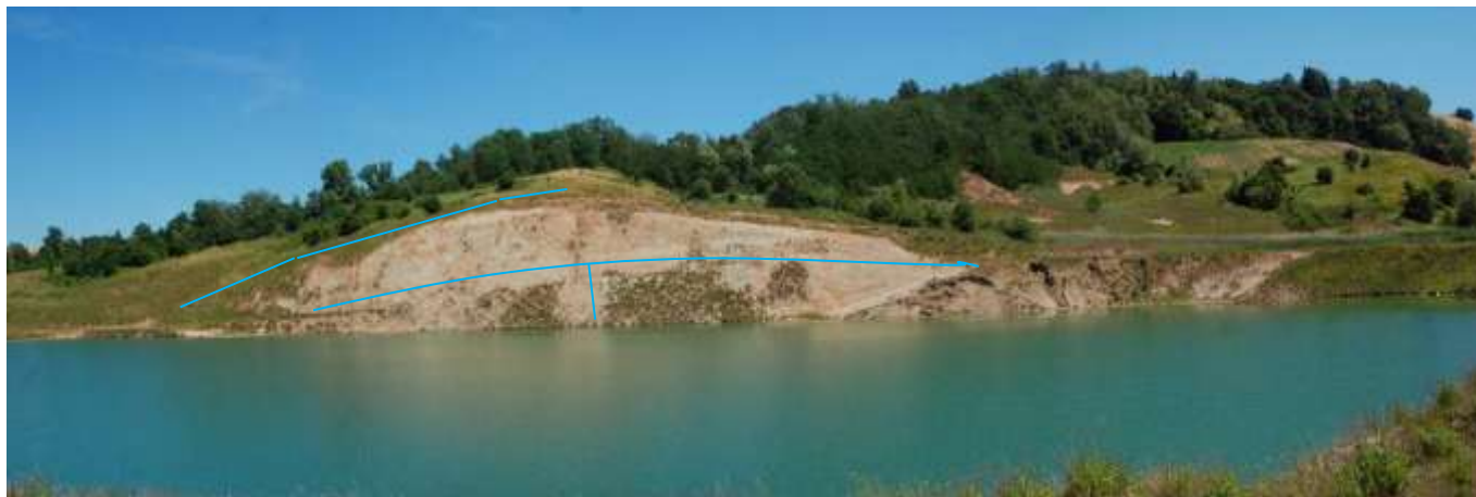
Foto n. 5: fronte nord, con la linea blu i collettori da realizzare.
