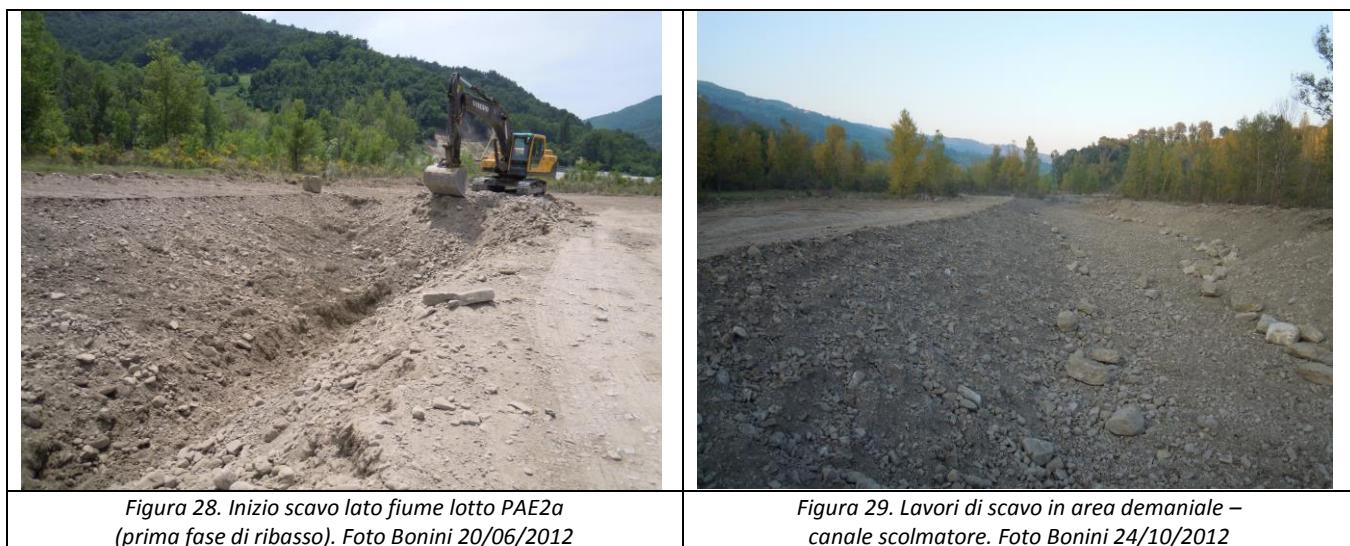
In una seconda fase sono stati eseguiti i lavori in area demaniale con l'asportazione di 19.978 mc di ghiaia alluvionale. I lavori hanno comportato la realizzazione, attraverso scavo ed asportazione, di un canale "scolmatore".
